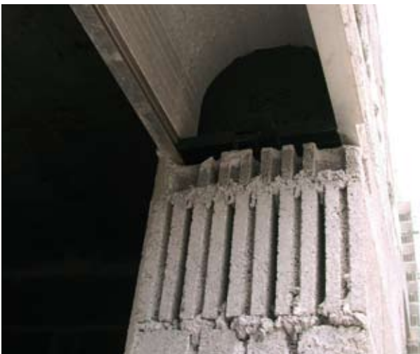
Exemple de mise en place d'un coffre tunnel pour volet roulant.
