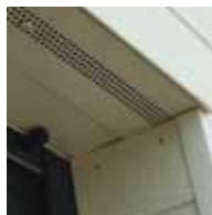
4b Larmier ventilé : assure en plus la ventilation au niveau du linteau.
