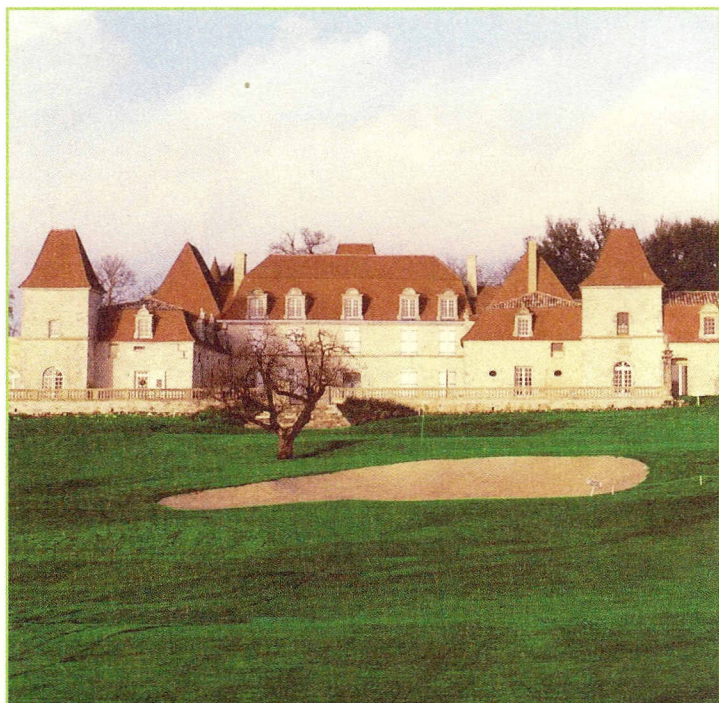
Château des Vigiers (24)
