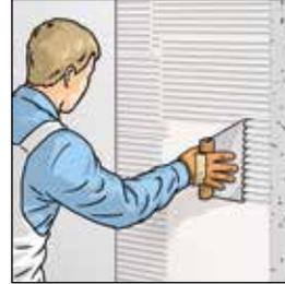
Appliquer uniformément le système de collage ERFURT-SR 4 perpendiculairement au sens du papier à l'aide d'une spatule crantée (en utilisant suivant le support la dentelure C3 ou B2). Pour éviter les problèmes d'adhérence, ne pas appliquer une couche de colle trop fine et ne pas enduire de colle une surface trop importante.
